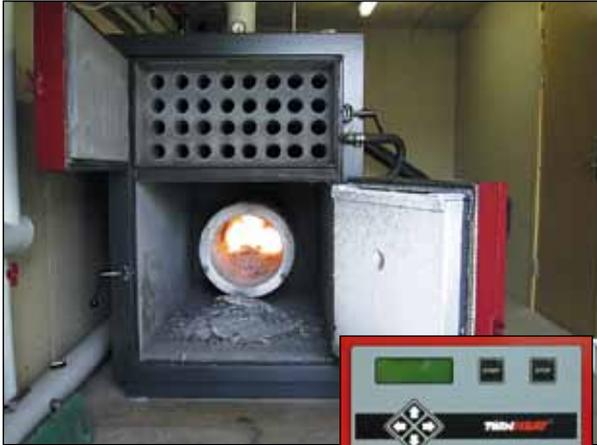
La puerta de gran tamaño proporcionará un buen acceso durante las inspecciones de la caldera o el quemador. La puerta superior proporcionará acceso al intercambiador de la caldera, donde se enfrían los gases de combustión.
