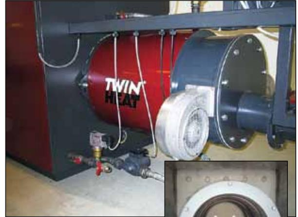
La combustión tiene lugar en el quemador refrigerado por agua. El aire de combustión del quemador se calienta a unos 300-400 °C.
