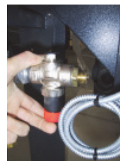
Sprinklerventil med afmonteret slange
