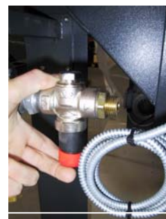
Sprinklerventil med afmonteret slange
