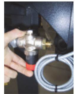
Sprinklerventil med afmonteret slange
