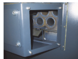
Røgekasse med afmonteret renslem
